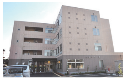
鉄骨造地上4階建て、居室55室を有する規模
