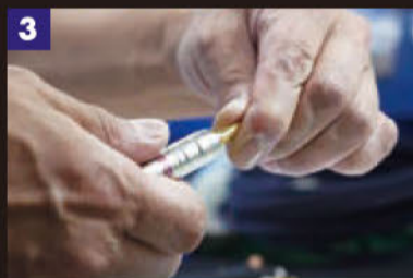
3 絶縁体やカバーを取り付けて完成。ケーブルのトラブルは接続部が多い。1つひとつ丁寧な作業が求められる
