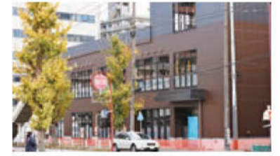
錦町駐車場跡地のCブロックの建設も着々と進む。スーパーマーケットのオーケーやフィットネスなど来年3月中旬開店予定
